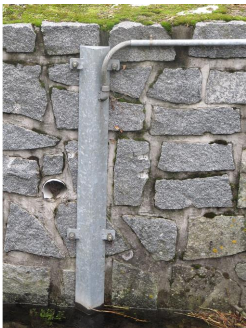
Obr. č. 13 Správně provedena instalace manometrické sondy
