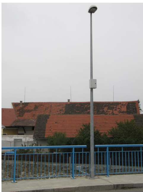
Obr. č. 17 Měřicí stanice dobíjena ze sloupu panelem veřejného osvětlení
