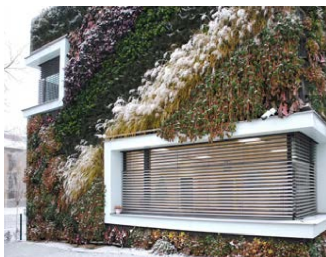
Obrázek 78: Zelená fasáda v zimě. V předjaří se trvalky a traviny stříhají na 5 cm, stálezelené rostliny se redukuje dle potřeby. Jednou měsíčně se doplňuje hnojení. (Přístavba sídla ombudsmána na ulici Údolní v Brně, foto archiv autorky projektu Jany Vrbasové).
