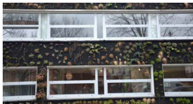
Obrázek 71: Bezsubstrátový systém v zimě
