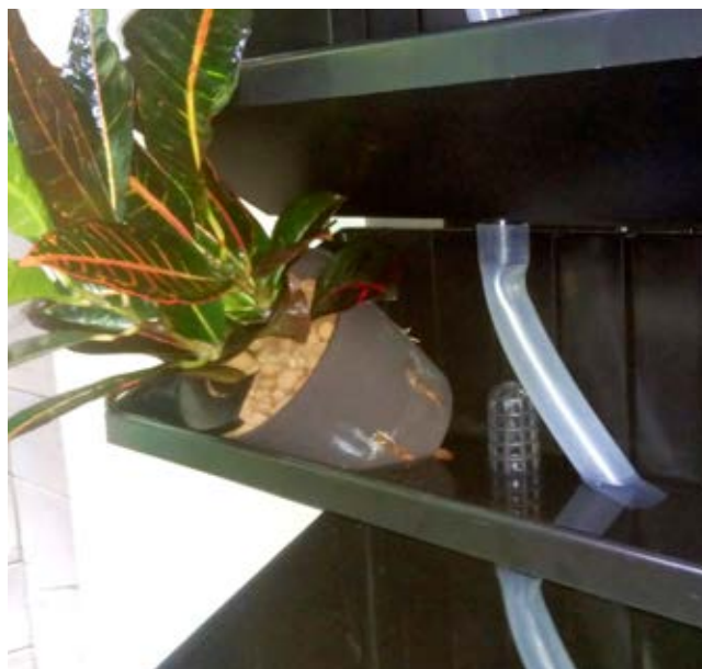
Obrázek 74: Modulární systémy, kde moduly tvoří jednotlivé květináče, jsou často zavlažované podmokem. Závlaha pak probíhá periodicky napuštěním vody do „podmisek“ a rozvody vody větších dimenzí se tak snadno neucpou jako kapková závlaha. Zde se jedná o interiérové provedení, stejný princip se uplatňuje i v exteriéru.
